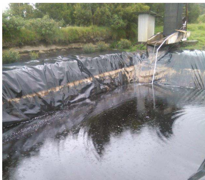
Figura 2. Piscina de lixiviados, punto de muestreo, medición de parámetros in Situ
